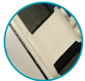
콘센트의 몸체 결합부도 실리콘을 이용하여 안전
